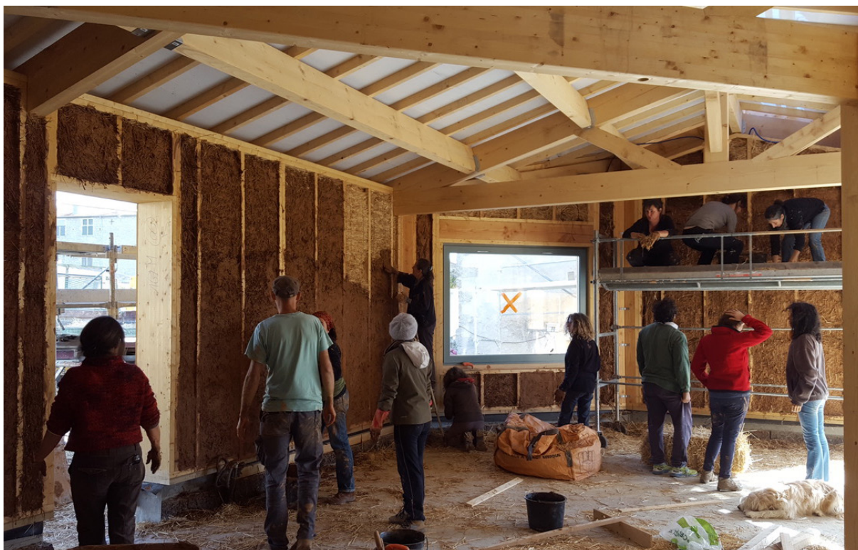
Construction frugale de la nouvelle mairie de VIENS (84), dans le cadre d'un chantier participatif associant les habitants, le maire de la commune, une association d'insertion et le groupe frugalité PACA.
